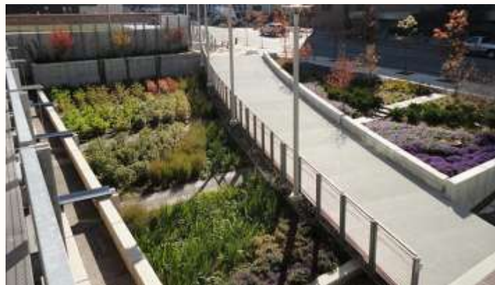
FIGURA 3 – Canteiros implantados com o sistema jardins de chuva.
