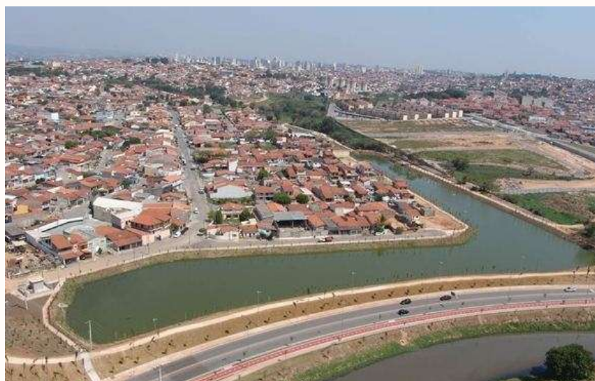
FIGURA 4 – Vista aérea da bacia de contenção de Sorocaba.
